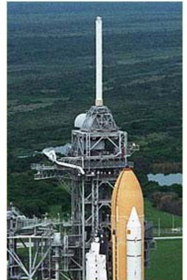
El mástil del pararrayos sostiene un largo y grueso cable tendido como "V" invertida, que es el verdadero protector de la plataforma contra las descargas eléctricas atmosféricas.
